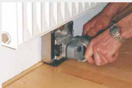
Tagliare giunto di dilatazione sotto elemento riscaldante
